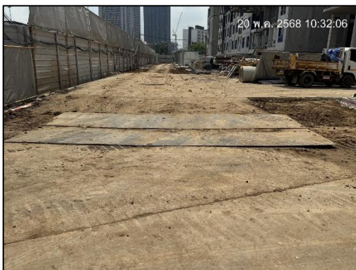
ภาพที่ 20 แผ่นเหล็กปูพื้นถนนสำหรับรถวิ่งผ่าน
