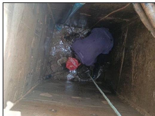
ภาพที่ 52 ขุดลอกตะกอนดิน
