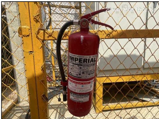
ภาพที่ 34 ถังดับเพลิงเคมี และป้ายแนะนำการใช้งาน
